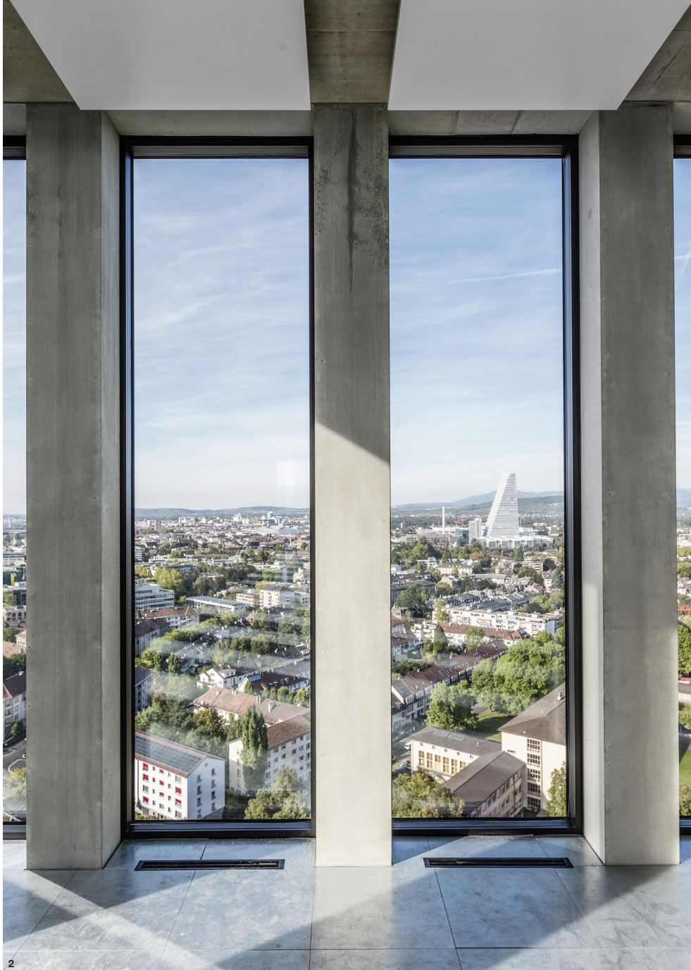
2 Die ausbetonierte Stahlrahmenkonstruktion ermöglicht viel Flexibilität im Innenausbau. Foto: Adriano Biondo
