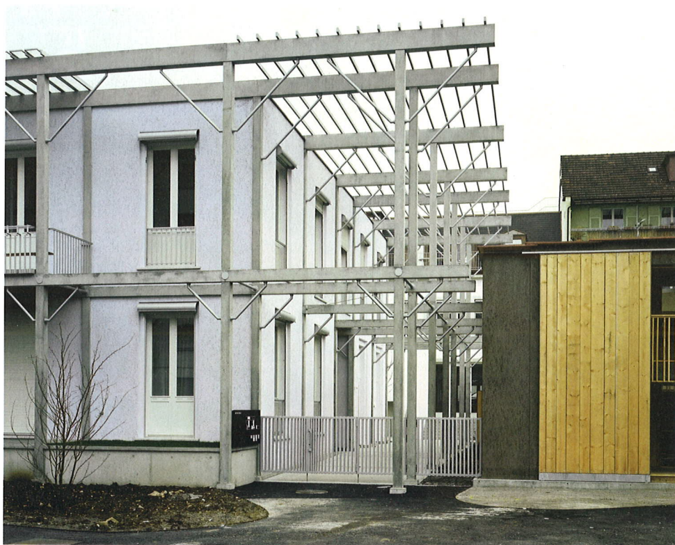
^ Das Gerüst aus Beton und Stahl legt sich wie eine zweite Haut über die gedämmten Aussen- wände. Im Hinterhaus trägt es die Balkone.
