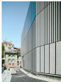
Rippen beleben die geschlossenen Fassaden.
