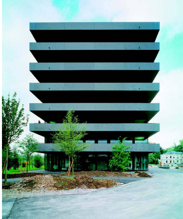
^Die weit ausladenden Balkone unterstreichen die Schichtung des Bürohauses vom City Gate Basel.
