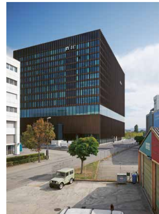
Am Rande des Gewerbegebiets erhebt sich der imposante, 64 m hohe Kubus, der fünf Hochschulen in einer stadtgleichen Anlage vereint.
