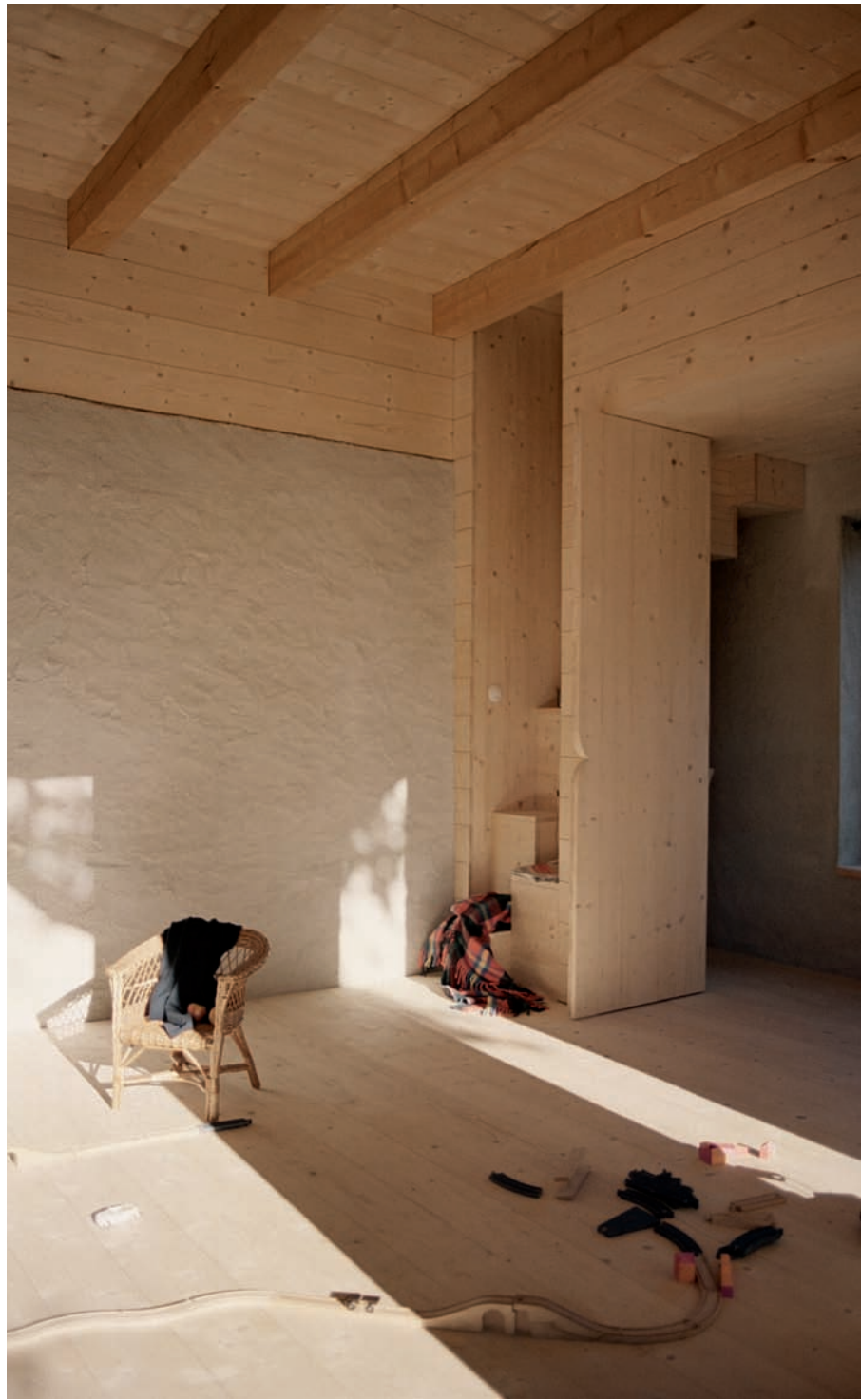
Mit dem groben Verputz auf der alten Natursteinwand bleibt die Geschichte des Ortes ablesbar.
