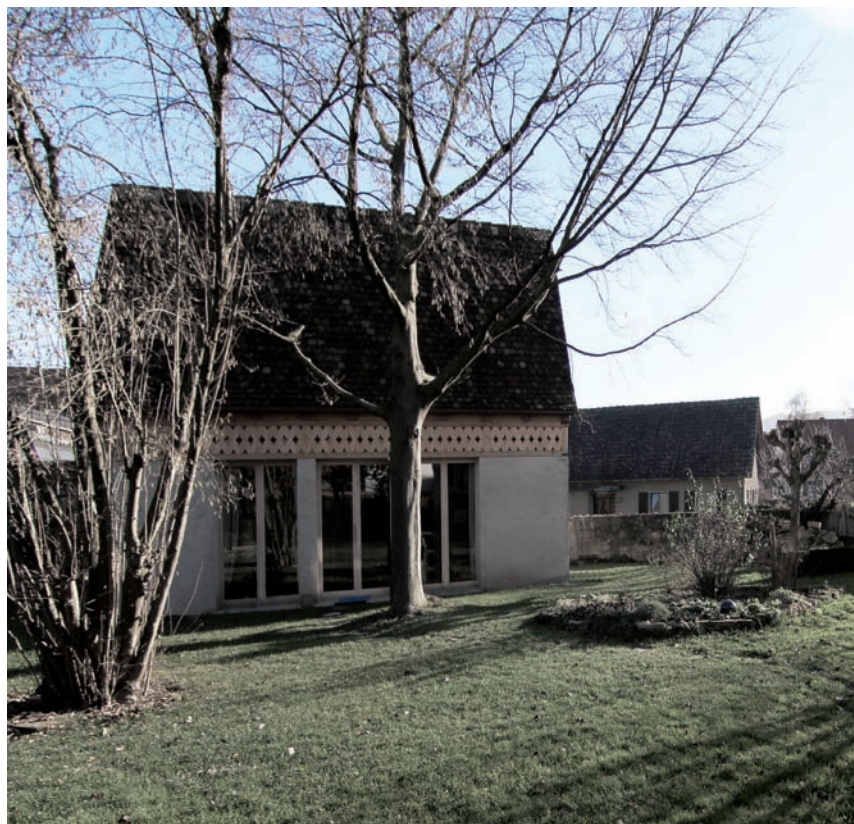
Zum Garten öffnet sich das Einraumhaus durch drei raumhohe Fensterflügel.
