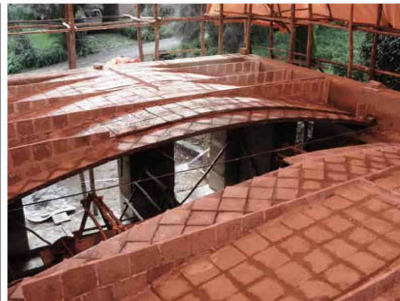
In Bearbeitung: Sicht auf die Konstruktion des Sudu (Sustainable Urban Dwelling Unit) in Addis Abeba, Äthiopien. Tragwerk von der Block Research Group, 2010.
