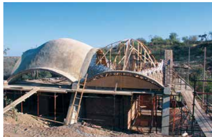
Konstruktion des Mapungubwe National Park Interpretation Centre in Limpopo, Südafrika, 2008.
