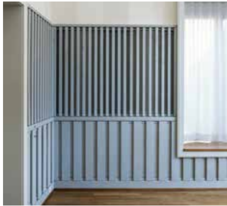
Wandvertäfelungen sorgen für eine wohliche Atmosphäre und dienen der Akustik.
