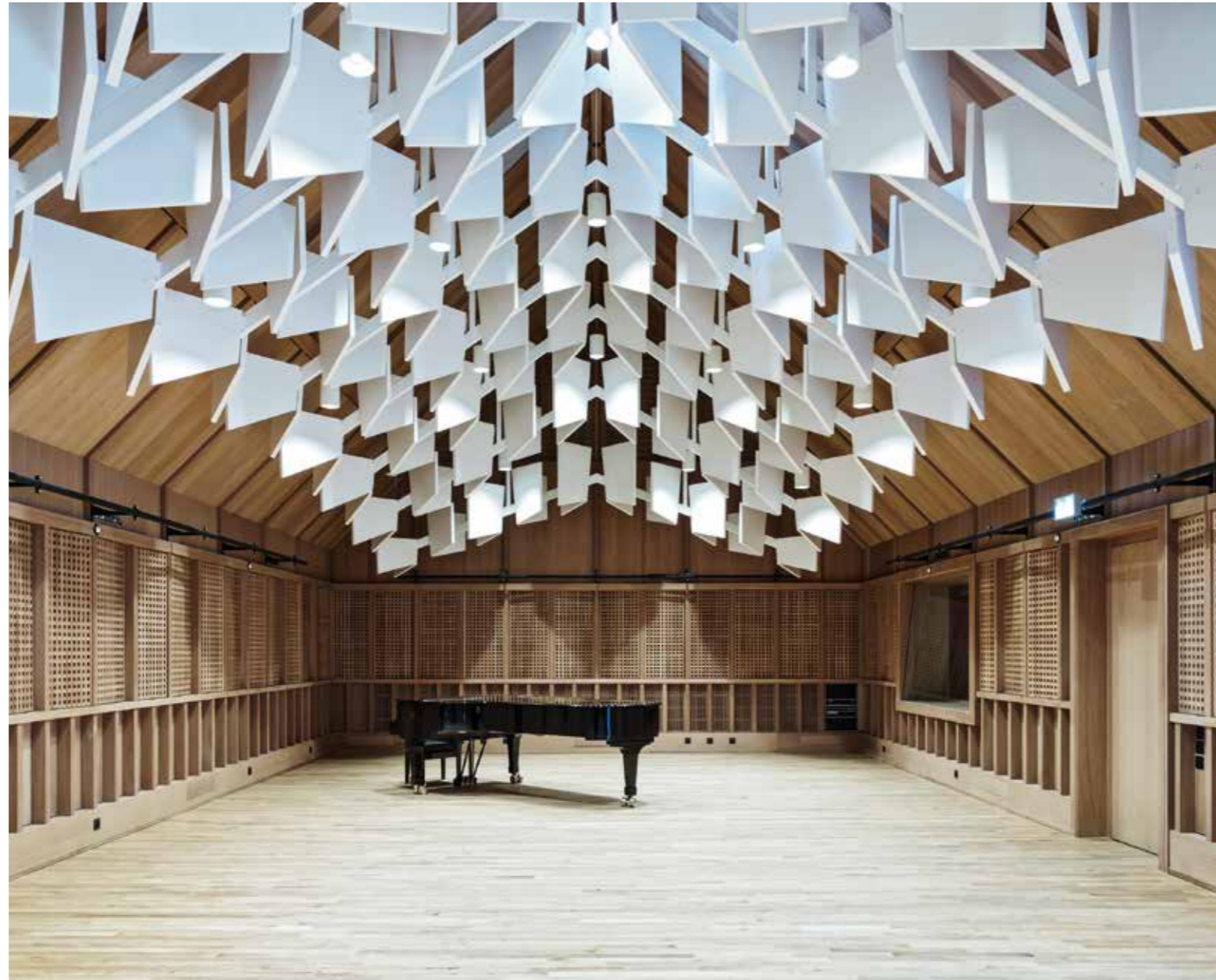
Bewegliche, von der Decke abgehängte Akustikpaneele und viele andere Details im Konzertsaal unter dem Dach dienen der Akustik und tragen zur besonderen Atmosphäre bei.
