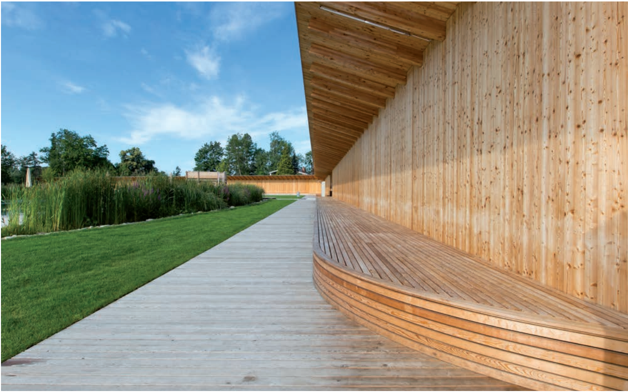
Gegen Norden und Westen offeriert die Holzkonstruktion ein über 200m langes überdachtes Solarium.
