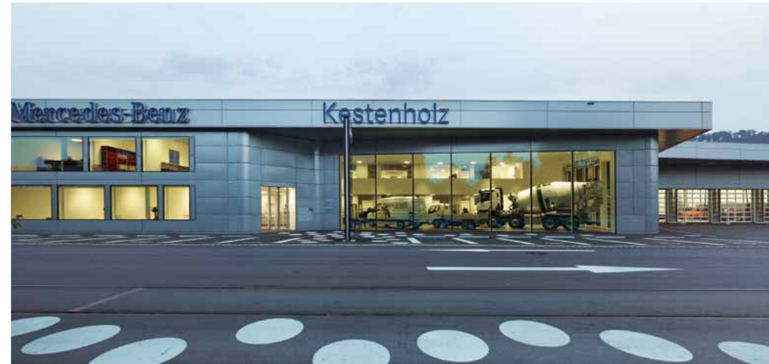
Die Fassade aus silberfarbigen Sandwichelementen interpretiert die vorgegebene Wellblechfassade neu.
