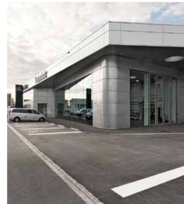
Die Fassade aus silberfarbigen Sandwichelementen interpretiert die vorgegebene Wellblechfassade neu.
