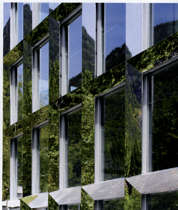
In den Fenstern und der Fassade aus hochglanzpolierten Edelstahlblechen spiegelt sich die Umgebung.
