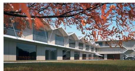
05 «Plissee» (Enzmann Fischer Partner Arch.): Zwei versetzte Volumen bilden grosszügige Freiräume. Die Jury schätzte die Sheddächer als Analogie zum Umfeld, allerdings werde die Schule «erst bei näherer Betrachtung ersichtlich»
