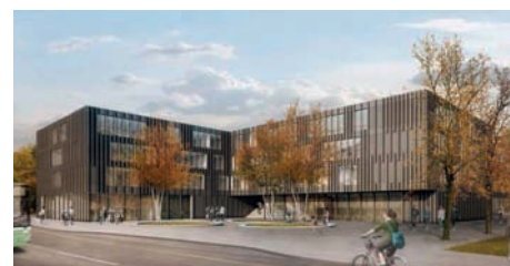
09 «4 hoch 3» (Phalt Arch.): Ein kompakter, dreiflügeliger Baukörper ermöglicht eine Konzentration der Aussenräume. Zentrum der Anlage ist die abgesenkte Turnhalle, deren Dachfläche als Sport- und Pausenbereich dient
