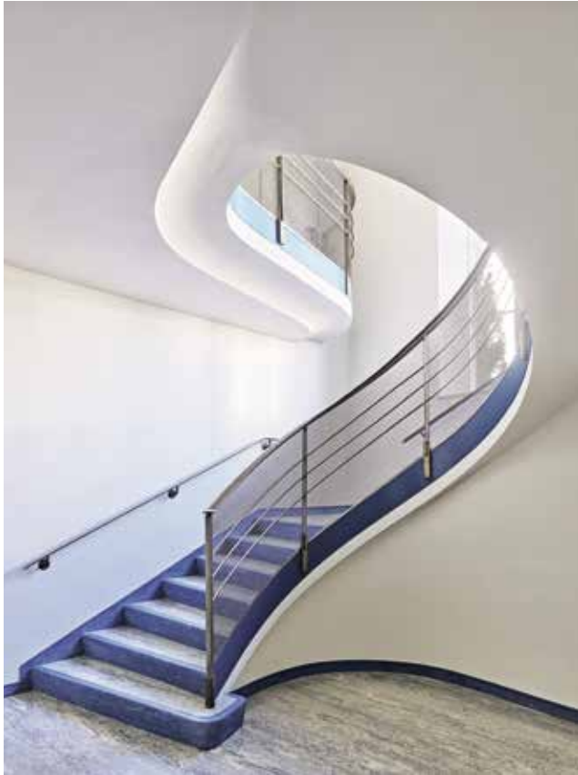
Aufgang zur Sonntagsschule. Die für Salvisberg typischen, elegant geschwungenen Treppengeländer wurden an heutige Gesetze angepasst: Um möglichst wenig in den Bestand einzugreifen, hob man die Geländer um 18 cm an und befestigte sie mit neuen, verlängerten Konsolen wieder an der Treppenwand.
