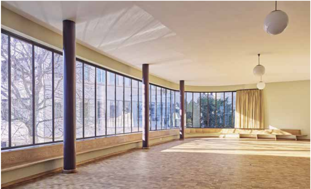
Die ursprünglichen gezogenen Glasscheiben der einstigen Sonntagsschule rüstete man in der Werkstatt zu Verbundgläsern auf.
