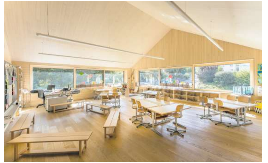
Helle Weissstanne verkleidet die Klassenzimmer gleich einer Tapete.
