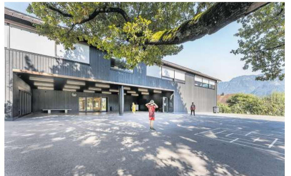
Die Fassaden sind aus dunkel lasierter Lärche und Fichte.
