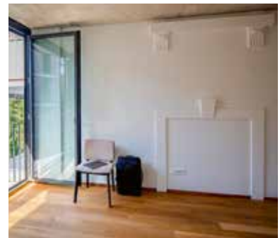
Die Laibungen, Simse und Lisenen der ehemaligen Fassade des Altbaus schmücken nun die Innenräume des Neubaus.
